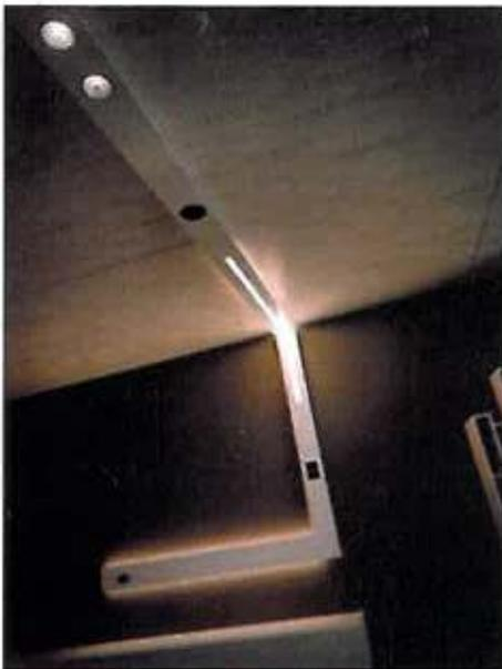
Segment è il nuovo sistema di illuminazione modulare a luce diretta, indiretta e a proiezione, funzionale e minimalista, di Lucifero's. I moduli finiti vanno da una lunghezza minima di 608 mm a un max di 3558 mm. I cablaggi proposti vanno dalla sola luce fluorescente t5 o con nuova tecnologia seamless a proposte di luce mista dove si coniuga ad una luce diffusa una luce d'accento data dai fari spot alogeni qr111 o led.
