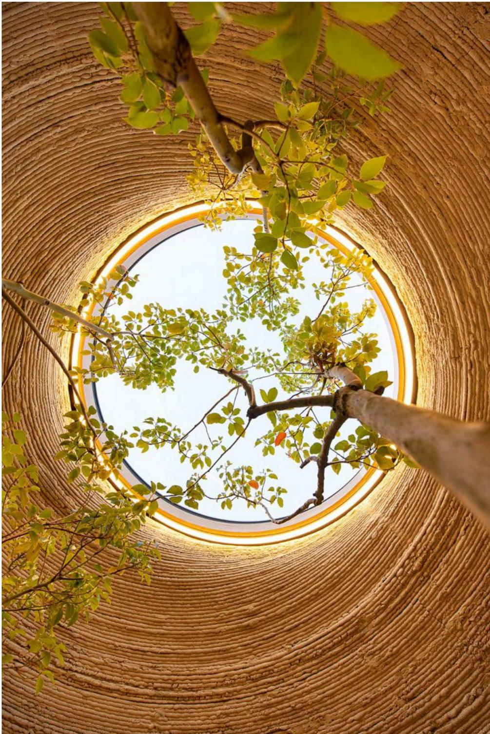
La forma peculiare di Tecla, dalla geometria di insieme alle creste esterne, ha permesso di ottenere l'equilibrio strutturale della costruzione, sia durante la fase di stampa 3D dell'involucro che una volta completata la copertura, dando vita ad un design organico e visivamente coerente.
