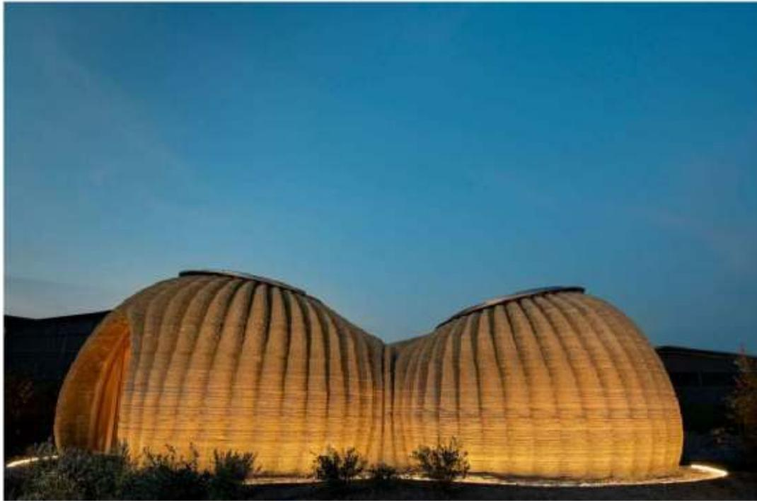
L'involucro di Tecla può essere sintetizzato in: 200 ore di stampa, 7000 codici macchina (G-code), 350 strati di 12 mm, 150 km di estrusione, 60 metri cubi di materiali naturali per un consumo medio minore di 6 kW.
