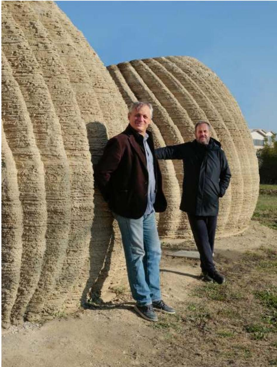
Per realizzare un modulo abitativo come Tecla, sono serviti 350 strati di 12 mm di terra cruda miscelata, 150 km di estrusione, 60 metri cubi di materiali naturali per un consumo medio minore di 6 kW. Il processo costruttivo può essere replicato grazie al kit costruttivo messo a punto da WASP, composto da molteplici stampanti 3D e da un sistema di prelievo, miscelazione e pompaggio dei materiali: il tutto può essere stipato e trasportato in un container.
